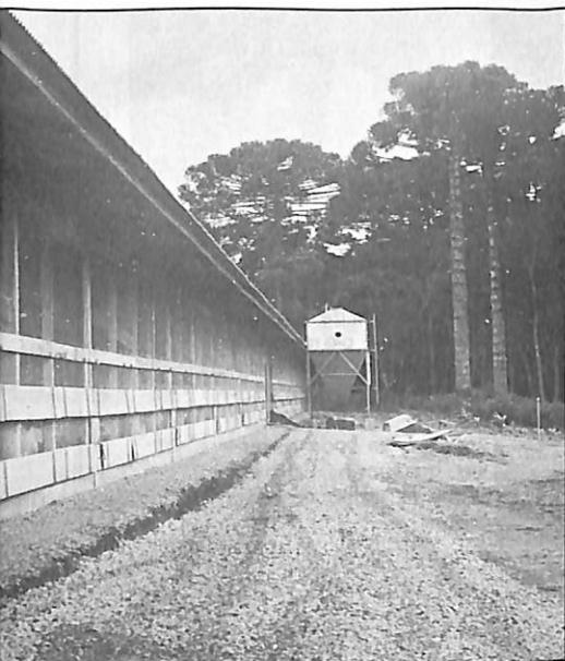
Vista de um galpão servido, por silo automático para distribuição de ração a granel e rodeado com telas, que impedem a penetração de ratos e passaros
