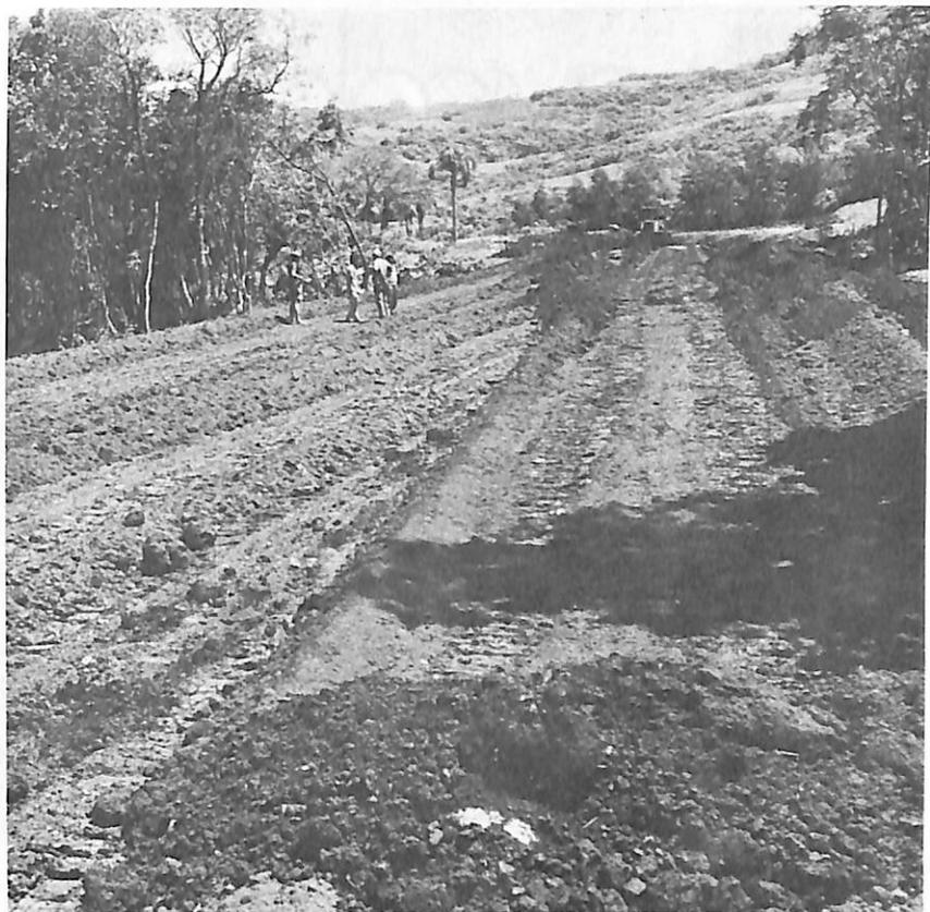
A granja nº 5, já está em construção. Na foto máquinas trabalhando na terraplenagem, onde serão construídos galpões de 160x10m.
