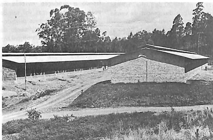
O terreno onde se localiza o aviário deve possuir uma inclinação suficiente que permita o rápido escoamento das águas das chuvas.
