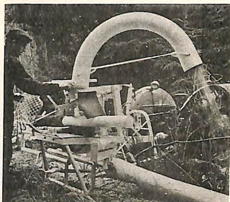
O descascador de troncos Cembro pode ser acoplado em qualquer trator sendo acionado pela tomada de força do mesmo, ou por motor a gasolina. Foi projetado para trabalhar no próprio local dos desmatamentos, descascando os troncos das árvores abatidas. Essa máquina é distribuída no Brasil pela Comercial Trilho Otero Ind. de Máquinas Agrícolas Ltda. (Rua Dona Teodora, 1461, Porto Alegre, RS).
