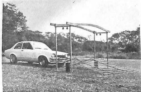
A Rovenco - Av. Sertório, 628, Porto Alegre, lançou a Cancela Automática Rovenco, que funciona com o peso do carro sem exigir nenhuma operação para abrir ou fechar. Segundo os fabricantes, sua instalação é fácil e sua durabilidade praticamente ilimitada já que é totalmente construída de aço de mola.
