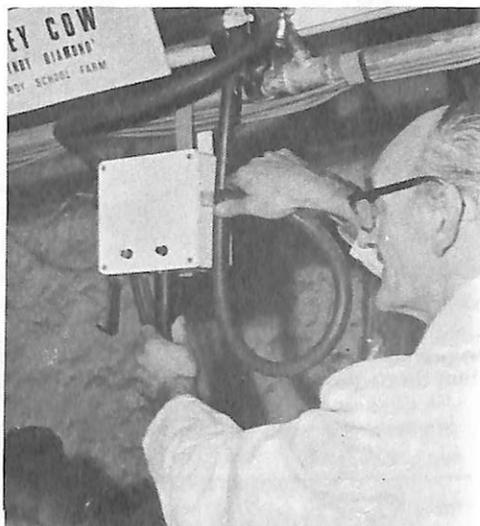
Este dispositivo – “Fraser Milk Abnormality Unit”, desenvolvido pelos britânicos, é capaz de detectar correta e precocemente a mastite.
