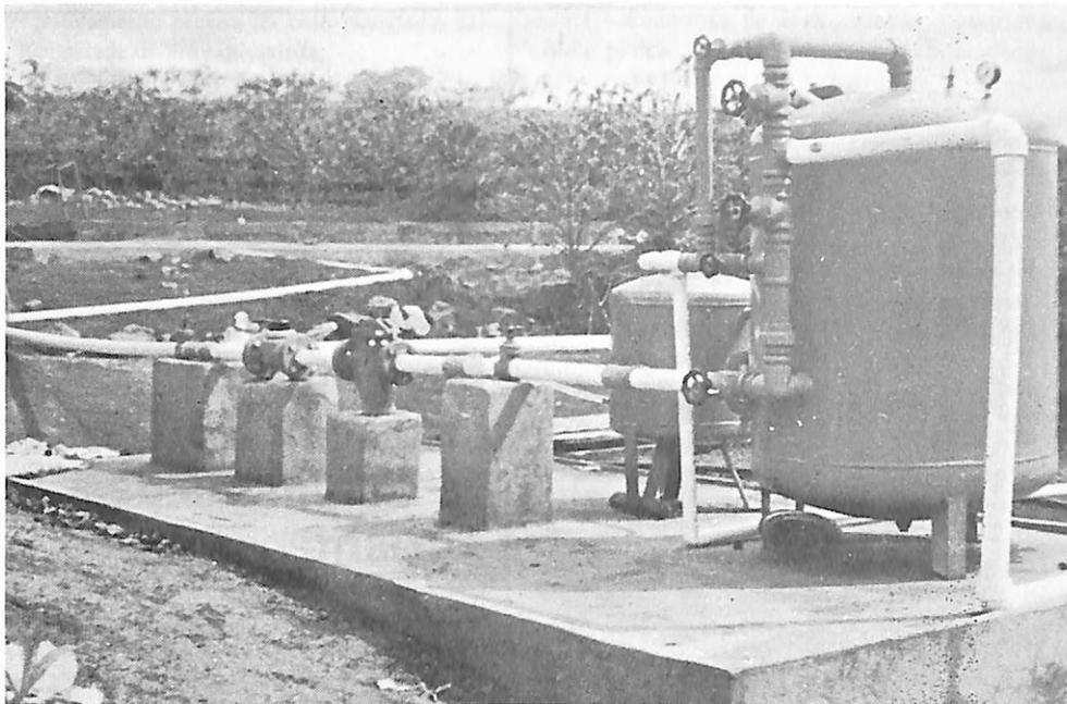
Cabeçal de controle do sistema, onde se vê filtros, válvulas, manômetros, hidrômetros, etc.
