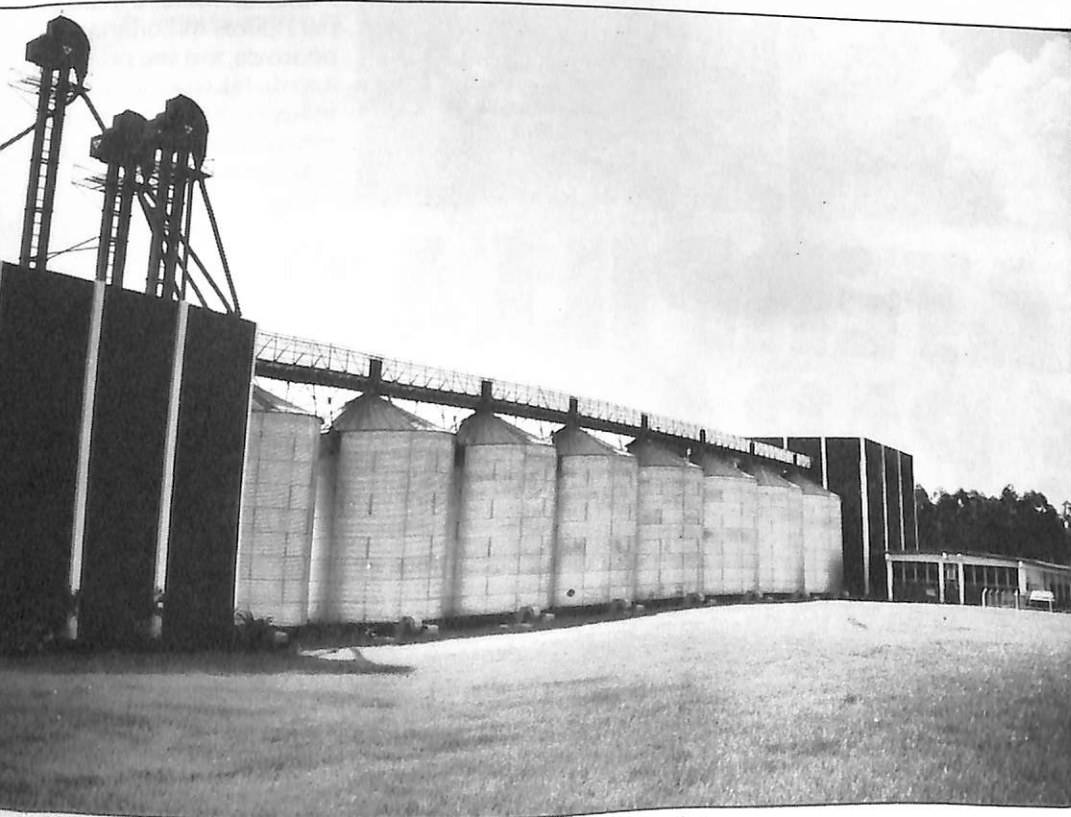
Rede de armazenagem é insuficiente
