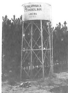
**CAIXA D'ÁGUA METÁLICA**
