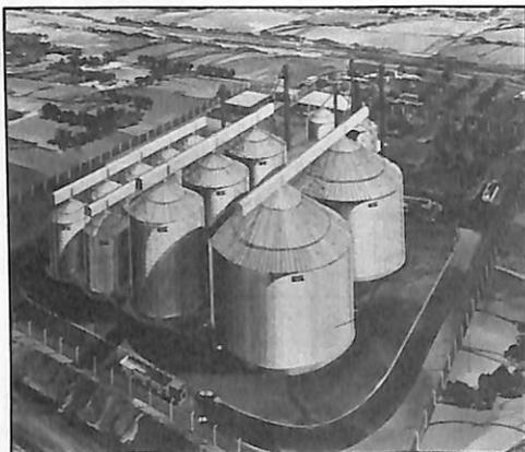
**Supersilo** — Com uma capacidade de estocagem para até 13 mil toneladas de grãos, o silo metálico SG-105 da Kepler Weber é o maior da América do Sul, com uma altura de 28 metros e diâmetro de 32 metros. Sua capacidade corresponde a mil caminhões médios carregados. Kepler Weber Industrial S/A., avenida Soledade, 40, fone (0512) 34.5366, telex 511881, CEP 90430, Porto Alegre/RS.
