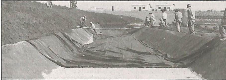
**IMPERMEABILIZANTE** — Fabricado em PVC elástico e de resistência uniforme, o Mat-keeper é mais econômico e de rápida instalação. O produto é confeccionado em mantas emendadas por solda eletrônica, prestando-se tanto para barragens, tanques, reservatórios, canais, bebedouros e açudes como também para armazenamento e proteção de sólidos em silos subterrâneos. Vulcan Material Plástico S/A., estrada do Colégio, 380, CEP 21231, Rio de Janeiro/RJ, fone (021) 371-3636.
