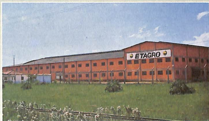
Vista panorâmica da fábrica
