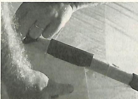
Colocação de seção de mangueira plástica como proteção do agrofílm no aço comum de construção (CA.50)
