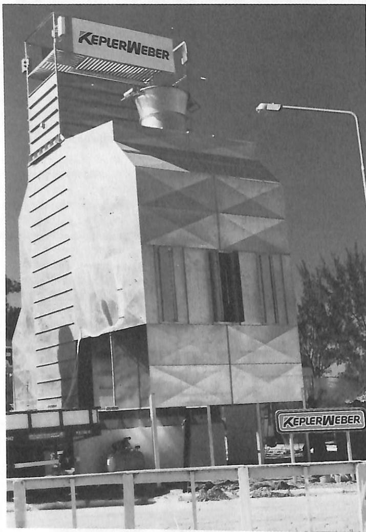
Secador dotado de Sistema de Filtragem de Pó
