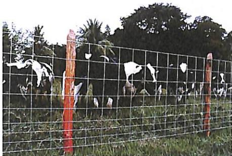
as necessidades de diversas regiões. É fácil de montar, apresenta alinhamento perfeito e dispensa as constantes manutenções. É soldada em todos os pontos de cruzamento dos fios. Fabricada com tripla camada de galvanização. Os fios externos têm bitola de 3,4mm, e os fios internos e verticais, 270mm. **Grupo Gerdau, av. Farrapos, 1811, CEP 90220-005, Porto**
