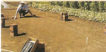
Primeiro passo: demarcar e nivelar a área
