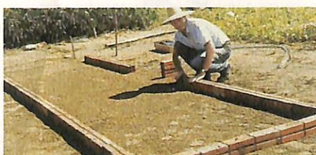
As bordas podem ser com tijolos ou madeira
