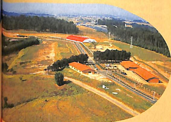
Vista Aérea do Empreendimento
