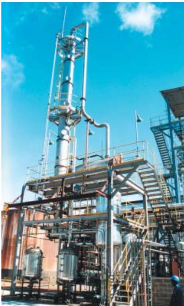
A produção de álcool pelo sistema DHR é realizada em três etapas: hidrólise, fermentação e destilação
