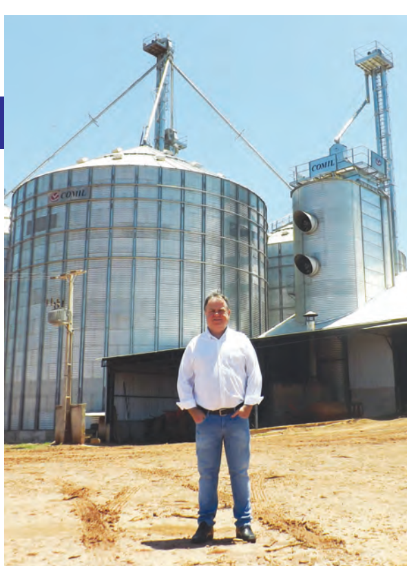
Segundo o gerente comercial da Comil Silos e Secadores, Rogério Specht, apesar do momento favorável para armazenagem, esse mercado tem muito ainda a crescer
