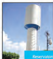
Reservatório Tipo Taça
