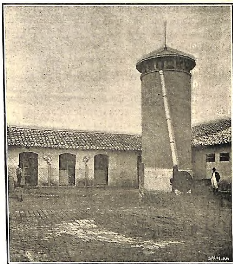
Grande silo cylindrico para armazenamento de forragem no Posto Zootechnico Central
