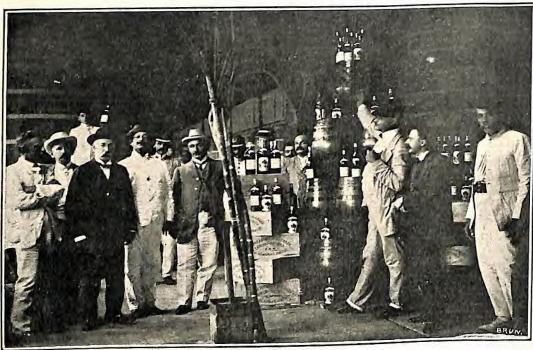
Vista do interior da fabrica
