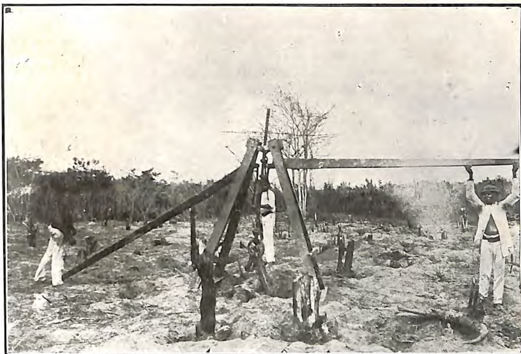
Destocador "Archimedes" em acção
