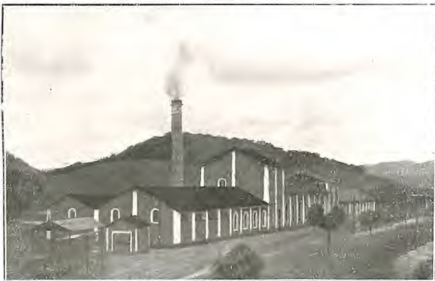
Vista geral do predio da Usina
