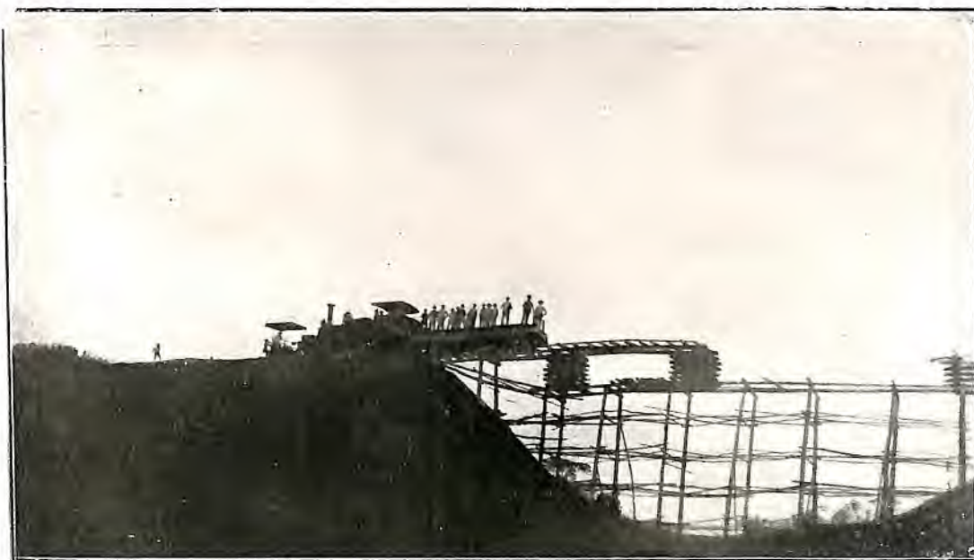
Aterra da linha ferrea construida pela Usina
