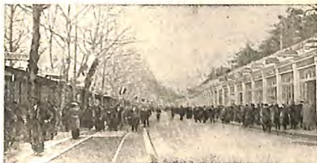
Feira de Lyon - Avenida do Palacio
