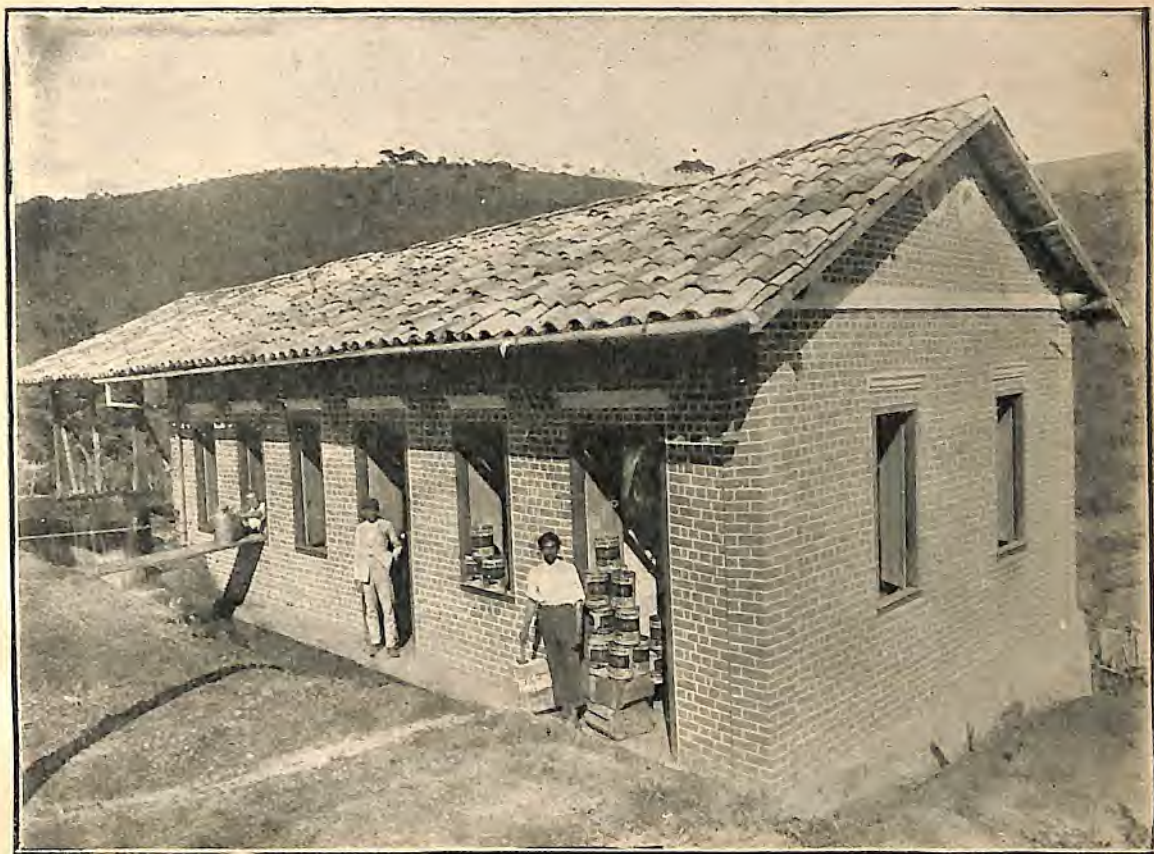
Pavilhão onde funciona a fabrica
