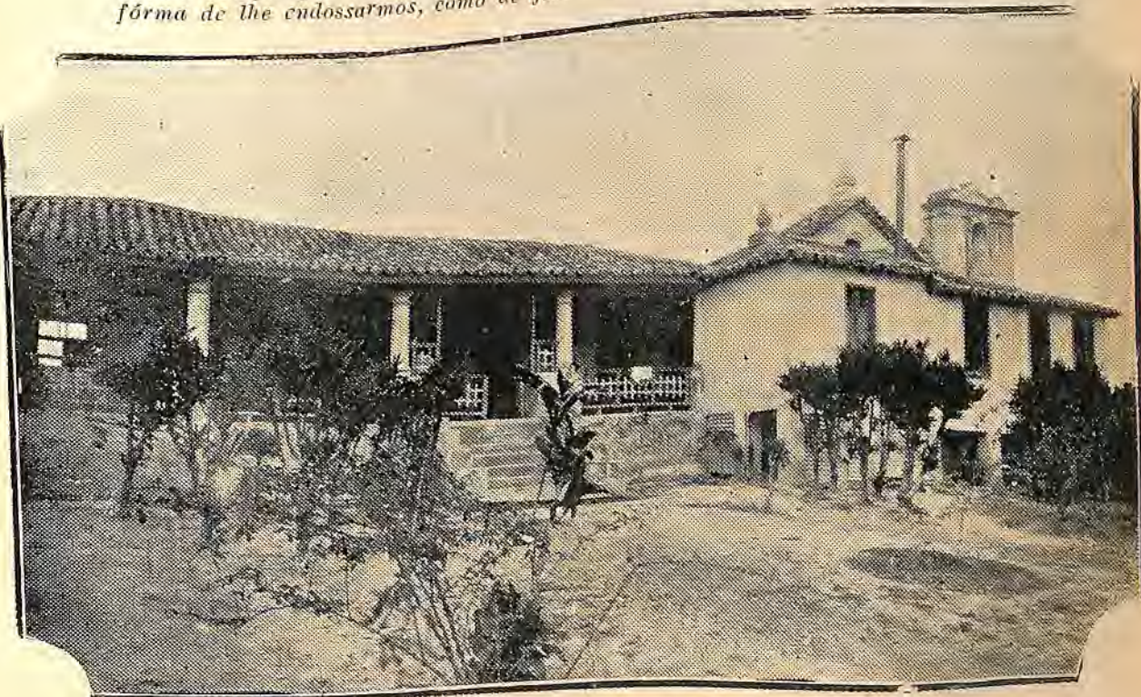
Edificio em que funcionam as aulas do Aprendizado Agricola
