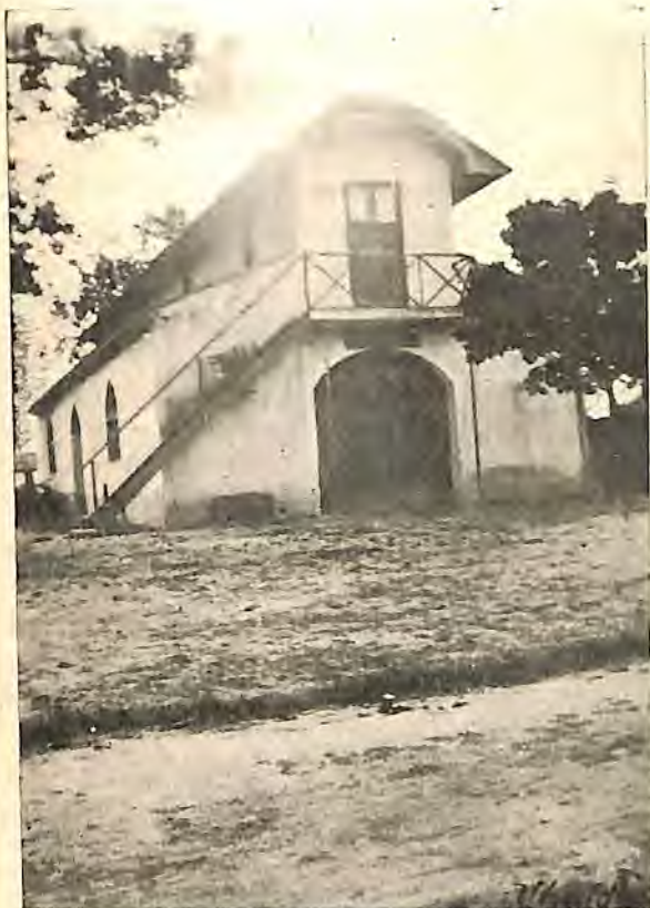
HORTO DA PENHA Deposito de machinas
