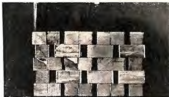
Secção transversal da arrumação no vagão. Observem-se os canaes deixados para a circulação do ar.
