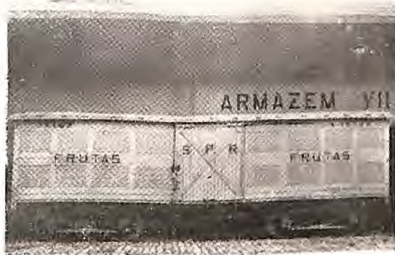
Vagão dotado de venezianas, cujos efeitos benéficos limitam-se ás caixas que estão proximas ás mesmas.
