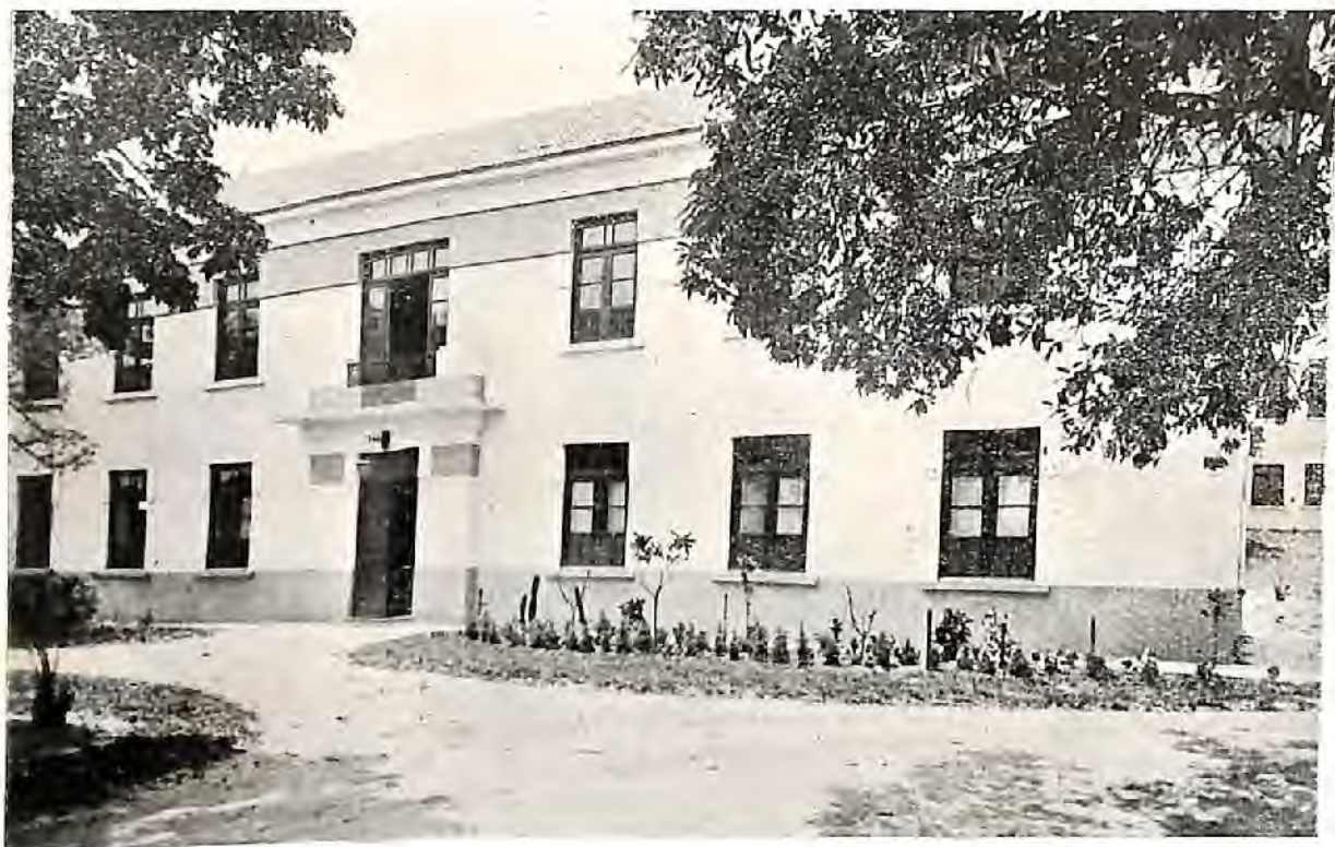
Pavilhão "Miguel Calmon" — Laboratorios, Gabinete e Salas de aulas.
