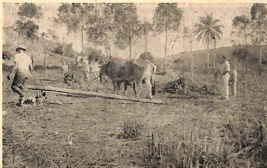
Durante o serviço. Observem-se os tócos arrancados
