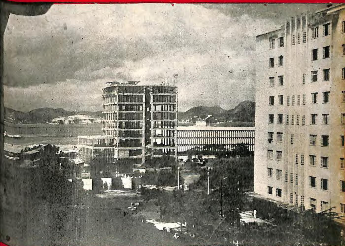
A Casa da Agricultura, com a sua estrutura em concreto armado já terminada. Desse importante serviço, bem como das alvenarias de tijolo e dos revestimentos internos, foi incumbida a firma CAVALCANTI JUNQUEIRA S. A., desta Capital, que aí demonstrou e vem demonstrando a sua alta capacidade técnica, justificando plenamente o acerto da sua escolha pela Comissão de obras da futura sede da Sociedade Nacional de Agricultura.
