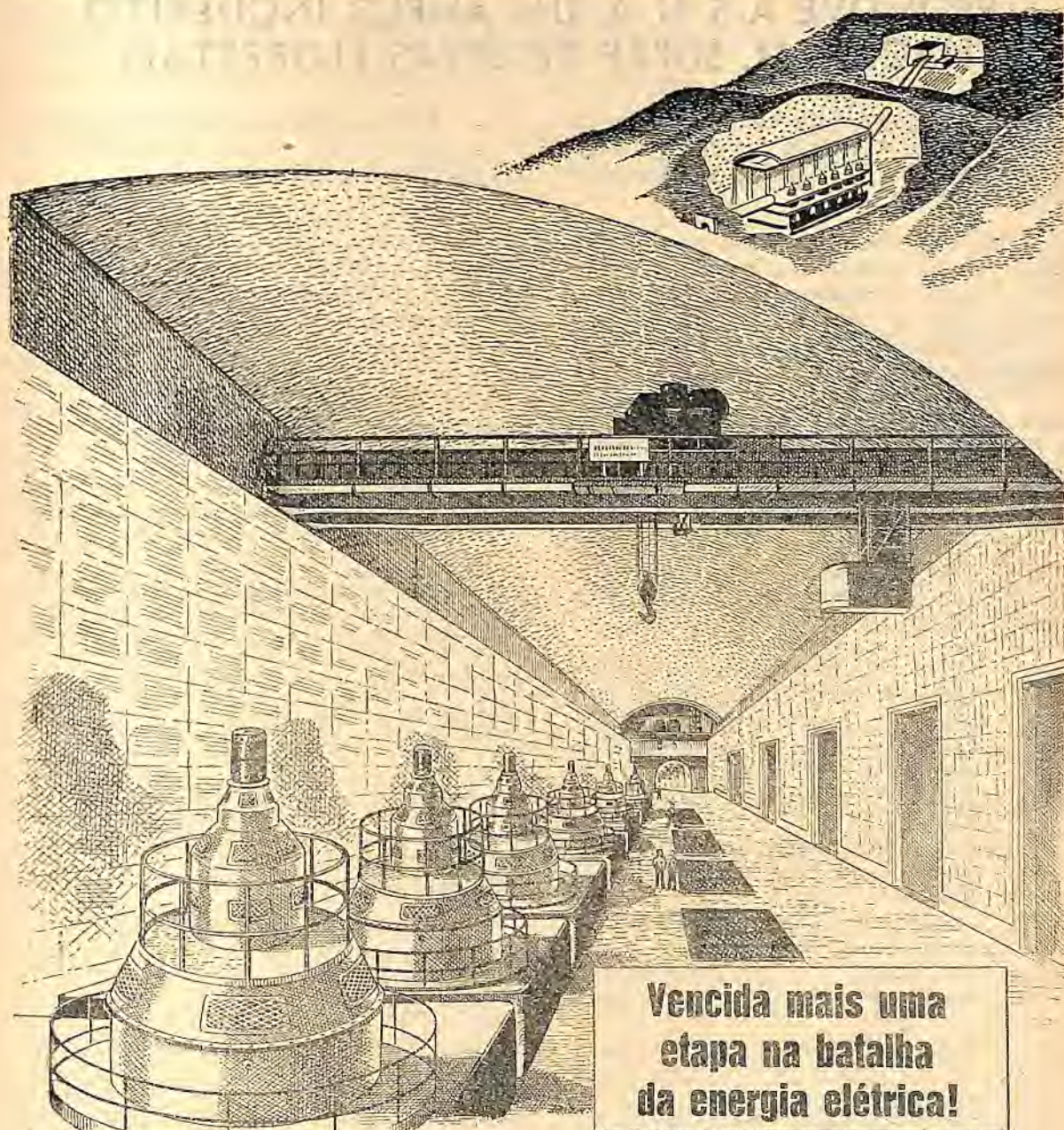
A USINA SUBTERRÂNEA NILO PEÇANHA, uma das grandes instalações hidroelétricas do mundo, tem seis poderosos geradores, que produzem 450.000 cavalos de força.
