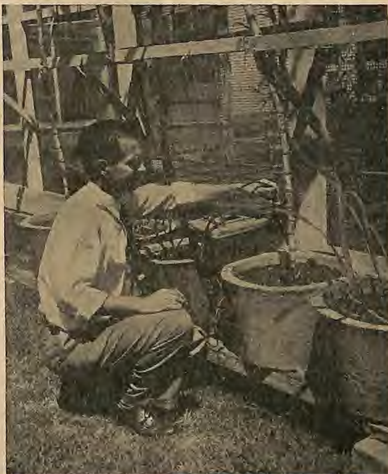
Empregando o medidor Geiger, este cientista calcula a infiltração dos radioisótopos neste pé de cana, possibilitando assim avaliar com exatidão as quantidades de fertilizantes necessárias para assegurar o bom crescimento da planta.
