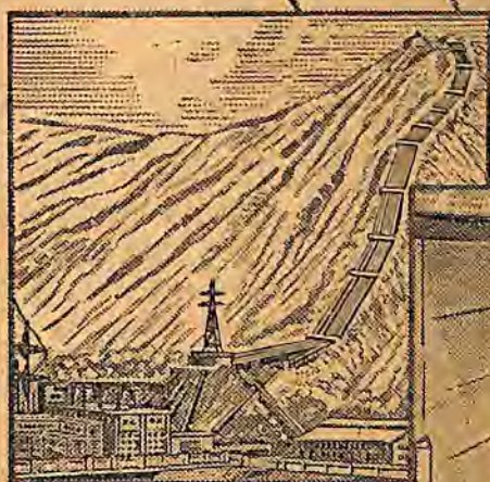
Usina de Cubatão com capacidade instalada de 483.000 kw é a principal geradora de eletricidade do sistema São Paulo Light
