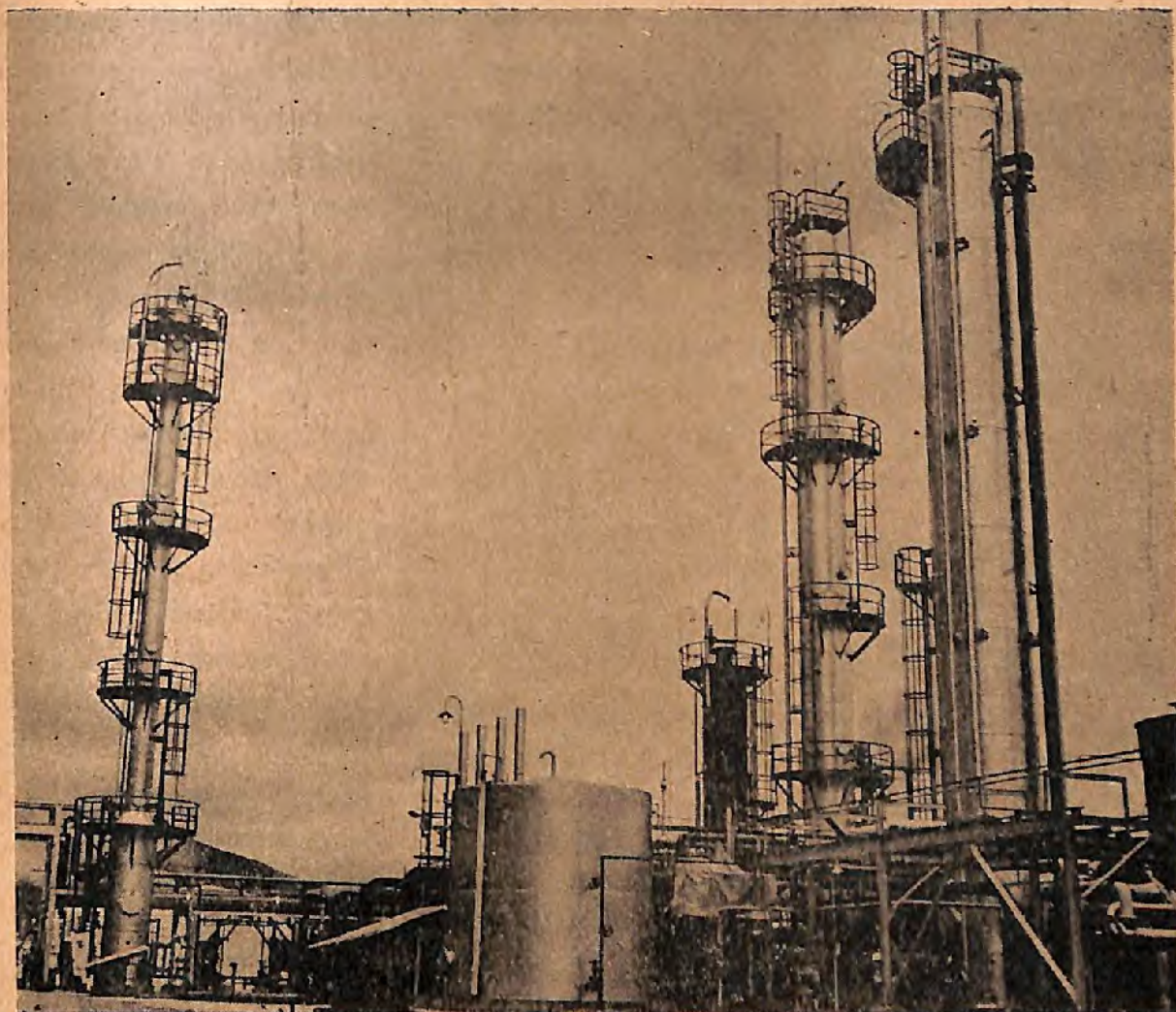
A fábrica de fertilizantes de Cubatão, ocupando uma área de 320.000 metros quadrados, tem capacidade para produzir diariamente 340 toneladas de calcitas e 34 toneladas de Sulfato de Amônio.
