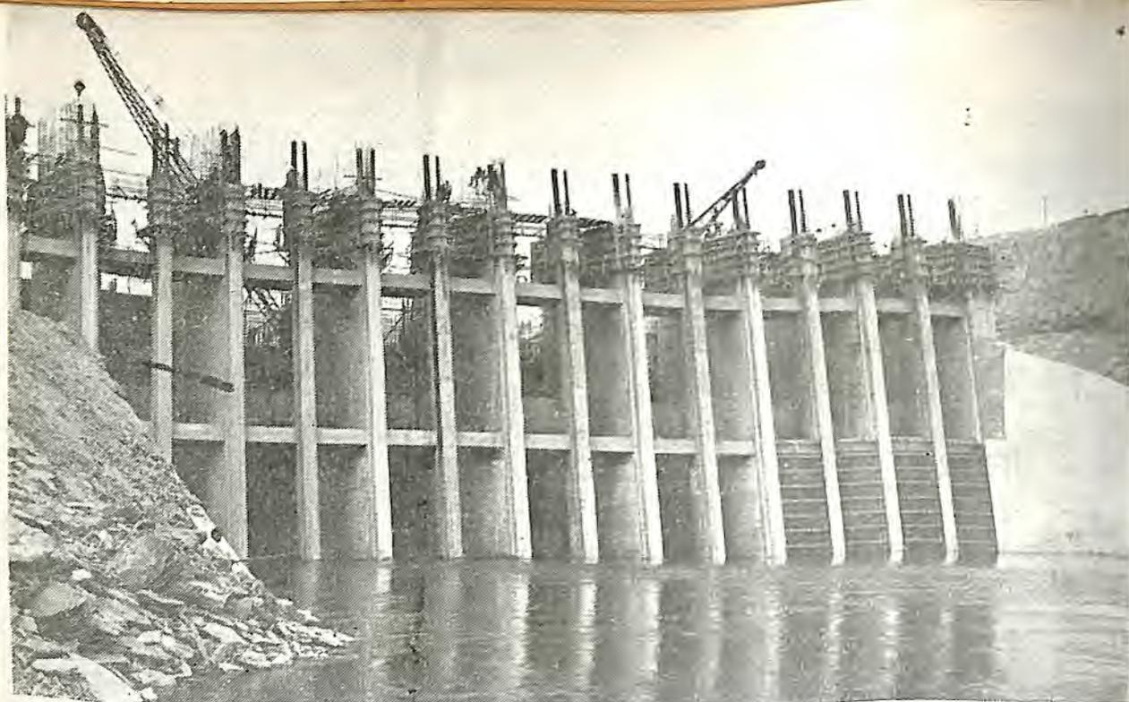
Sob o ponto de vista geométrico, a barragem terá 75 metros de altura sôbres as fundações, 600 metros de largura, com um volume de 18.000.00 de m<sup>3</sup> compácto, volume 7 vêzes superior à Baía de Guanabara. O paramento do montante é revestido por enroscamento e, abaixo da cota 541, existirá uma camada adicional de 0,30 de espessura de pedra de mão e fragmento de rocha, refugio de pedraira.
