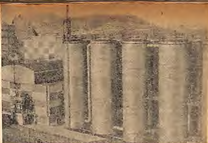
Unidade de ácido nítrico: utiliza como matéria-prima a amônia e o ar. Tem uma capacidade de produção igual a 348 t/dia de ácido nítrico a 52%.
