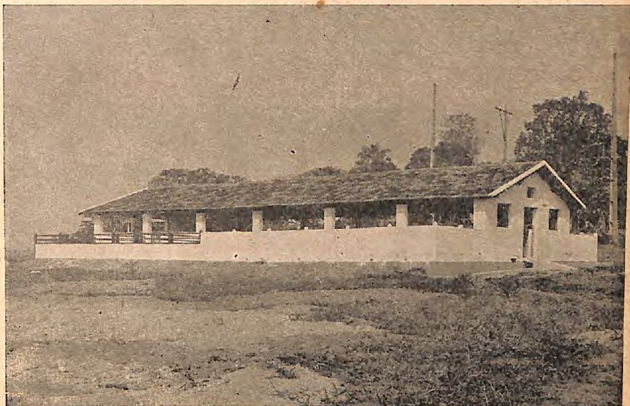
A pocilga nova após a reforma. Em baixo, vista interior
