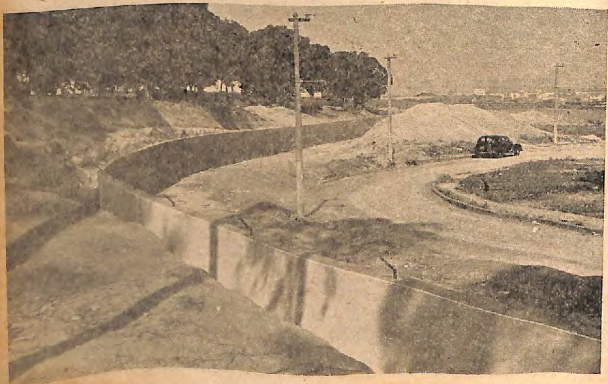
Em baixo, a mes.mo, trecho, após a construção do muro (fotos 1 e 2)
