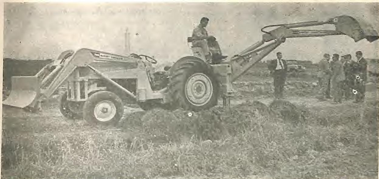
Um serviço a ser executado na lavoura, em setembro, é a limpeza dos canais de irrigação. A escavadora da foto acima abre valetas, esgotos e canais com o auxílio de um só homem: o operador
