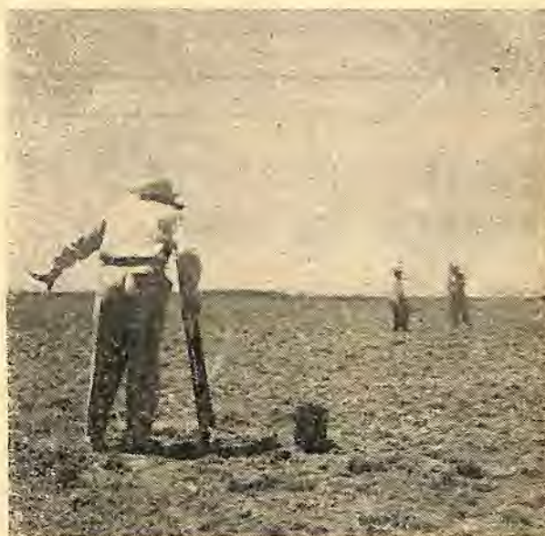
O nivelamento do terreno é de muita importância para a demarcação dos quadros e taipas.
