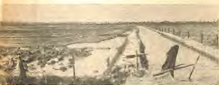
boa conservação das estradas depende de uma eficiente rede de sarjetas, valetas e valos para escoamento das águas das chuvas.
