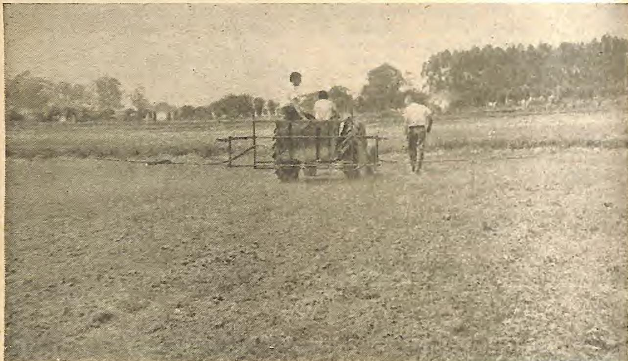
Pulverizador adaptável à tomada de força de um trator. E' utilizado sempre que se necessita pulverizar grandes extensões. Há um outro tipo, manual, empregado para o combate ao "capim arroz" quando êste aparece em manchas isoladas.
