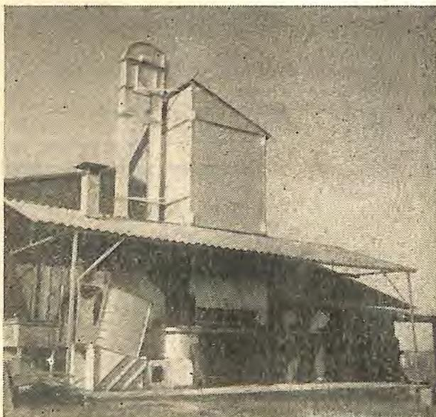
Ao adquirir um secador, é preciso verificar se pode ser carregado e descarregado facilmente. Também de grande importância é o espaço para depositar tanto o arroz seco, como o arroz destinado à secagem.
