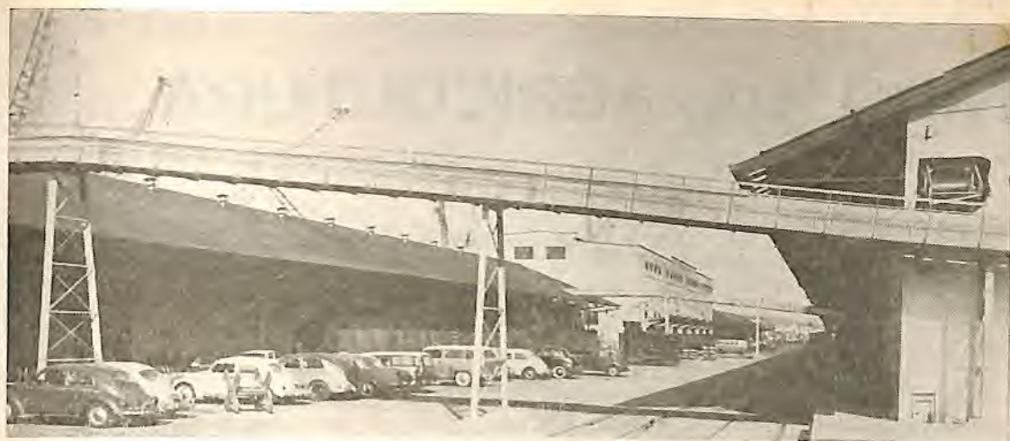
Novas instalações destinadas ao embarque de milho. Detalhe das esteiras transportadoras externas ligando os armazéns à faixa do cais.
