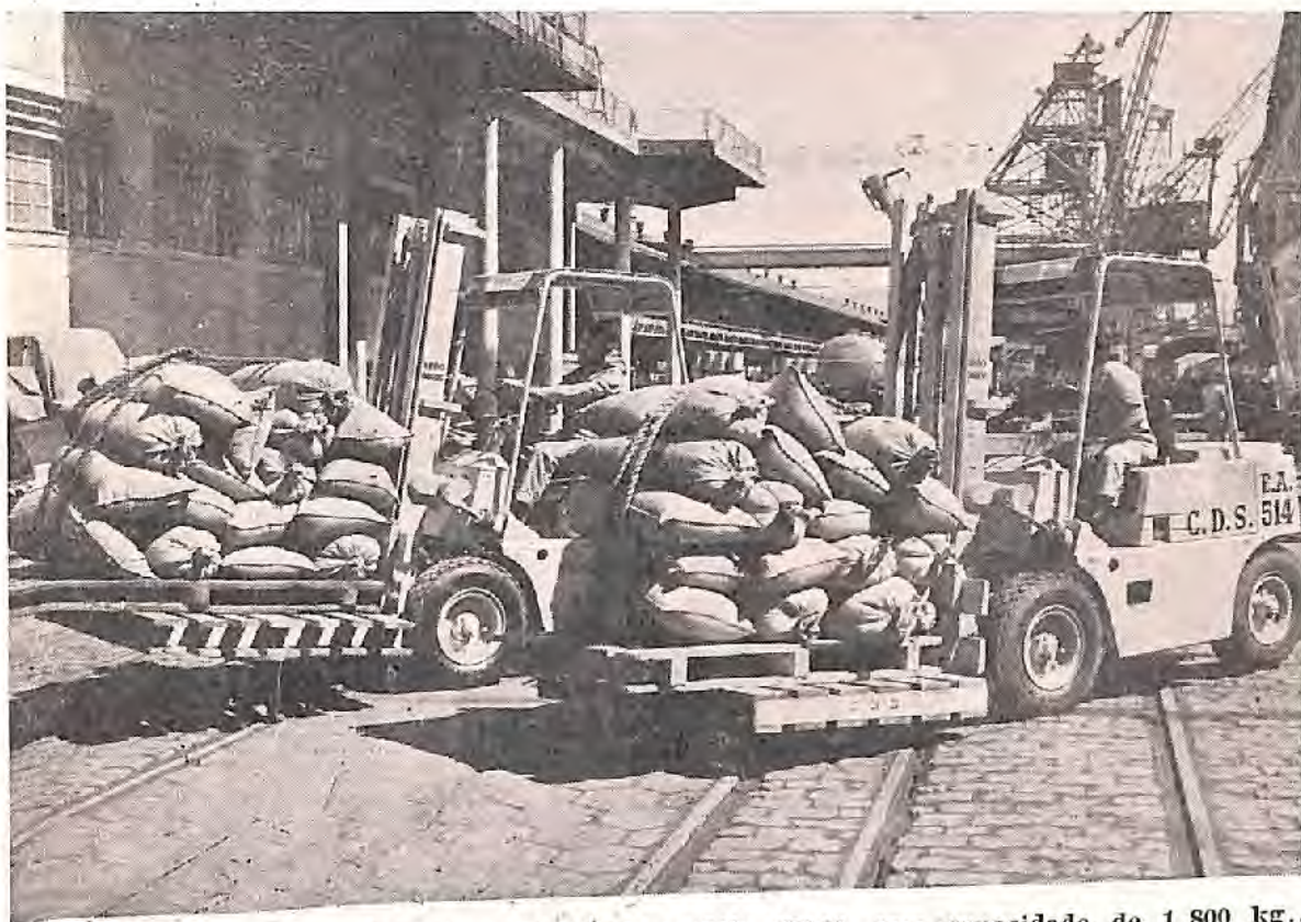
Dois das 16 novas empilhadeiras CLARKE, modelo CY-40, com capacidade de 1.800 kg., fabricação nacional, equipadas com transmissão hidráulica, recebidas pelo pôrto e já em operação na faixa do cais.
