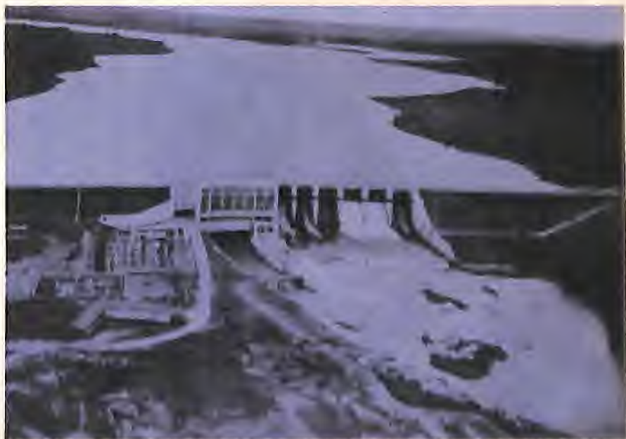
Usina do Mimoso iniciada há 12 anos. Planejada para produzir 60.000 kW já teve sua primeira unidade de 10.000 kW instalada.
