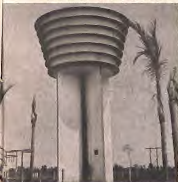
Reservatório de água de Aparecida do Taboado com capacidade de 210 m 3 .
