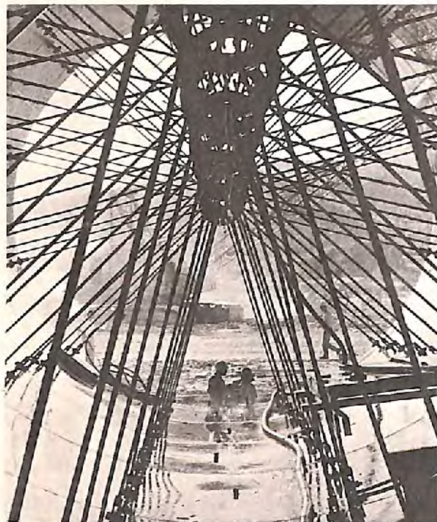
Instalação para adução de água às turbinas de Furnas, símbolo de uma nova era para o desenvolvimento das atividades rurais.
