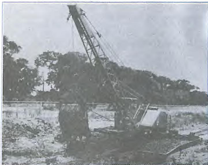
A construção dos grandes tanques de terra em áreas pantanosas exige, quase sempre, equipamentos de elevado custo que devem operar em condições extremamente penosas, com o recurso de pranchões servindo como lastro, a exemplo da foto acima colhido no sul do Estado da Louisiana, U.S.A.
