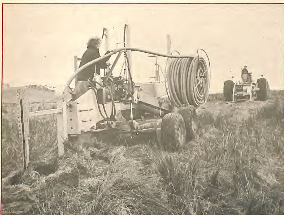
Uma demonstração de novo sistema de assentamento de tubos criado recentemente pela firma britânica Hudswell Yates Developments Ltd.
