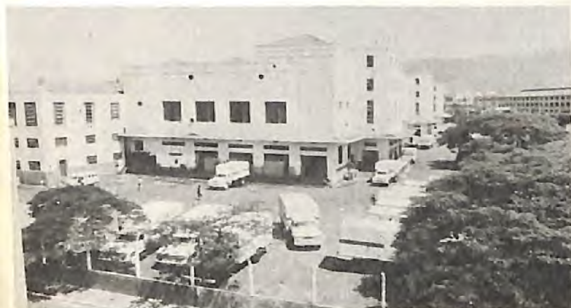
Usina Central (Rio de Janeiro-GB)
