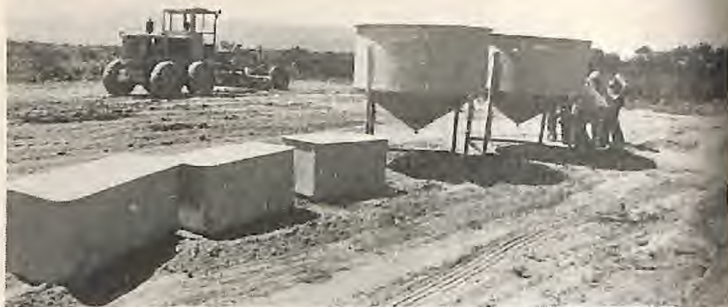
Laboratório de Maricultura de Guaratiba: Os grandes tanques circulares de fibra de vidro servem para a eclosão dos ovos e criação dos milhares de larvas disso resultante. Os tanques retangulares e menores, em um total de dez, destinam-se a cultura de algas para alimentação das larvas de camarões. A reportagem do Jornal do Brasil, a quem devemos a gentileza das fotos desta notícia, compareceu ao local no momento em que se constata o impasse diante do diâmetro dos tanques, que é de 1,80m, um pouco maior que a largura das portas do laboratório. Ao Engenheiro Agrônomo Dionísio Tolomei, Diretor da Fazenda Modelo, coube resolver o problema, o que fez com muito engenho e arte.
