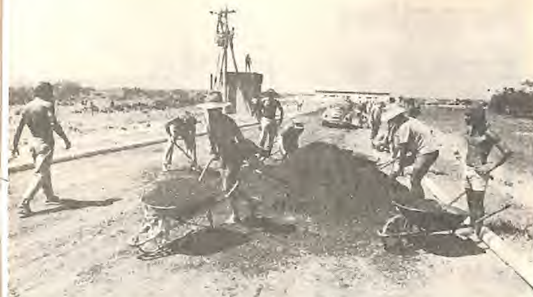
Laboratório de Maricultura de Guaratiba — Pavimentação da pista de acesso. A foto é gentileza da reportagem do Jornal do Brasil.
