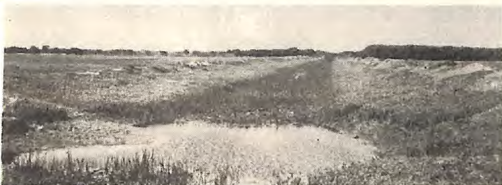
Canal Baixio — praticamente recoberto pela planta aquática. A sua limpeza poderia ser facilmente feita pelos proprietários da terra.
