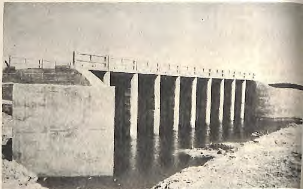
Vista da comporta automática dos canais São Bento e Coqueiro que juntamente com a do canal Quitunguta, eliminarão as enchentes provocadas pelos refluxos das marés.
