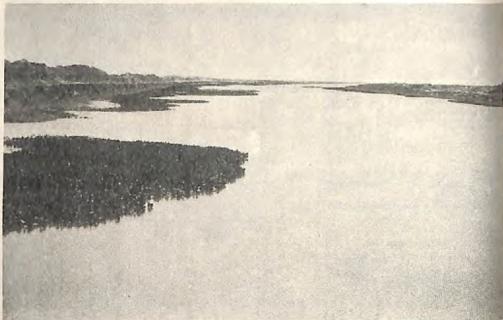
Canal Flexa que faz a ligação da Lagoa Feia com o mar, com quase 150 metros de largura é maior que o famoso Canal de Suez.
