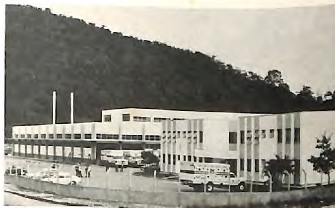
Fábrica Eduardo Duvivier-FAED (São Gonçalo-RJ)
