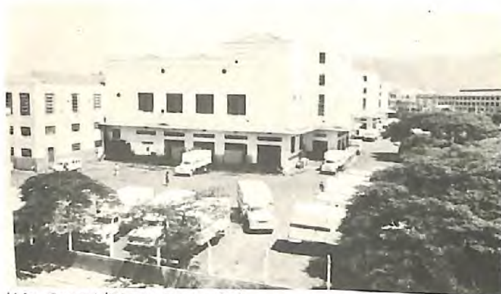
Usina Central (Rio de Janeiro-GB)
