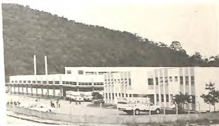
Fábrica Eduardo Duvivier-FAED (São Gonçalo-RJ)
