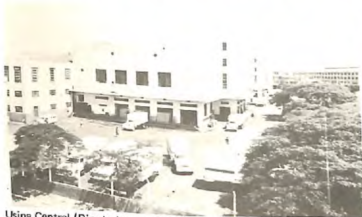
Usina Central (Rio de Janeiro-GB)
