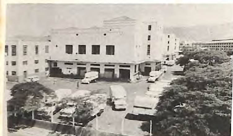
Usina Central (Rio de Janeiro-GB)
