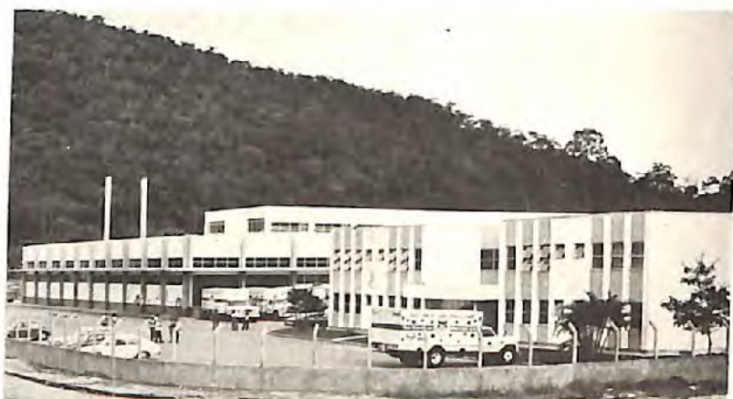
Fábrica Eduardo Duvivier-FAED (São Gonçalo-RJ)
