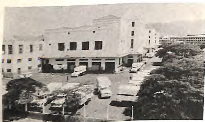
Usina Central (Rio de Janeiro-GB)
